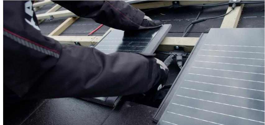
**1.** Før steinene legges på plass og kobles til delmatrise-kabelen (DJB) (bus-kabelen i underkant av lekta), skal hver stein og de elektriske tilkoblingene inspiseres visuelt. Solcellesteiner som har skade på stein, solcelle eller ledninger, skal ikke benyttes.
